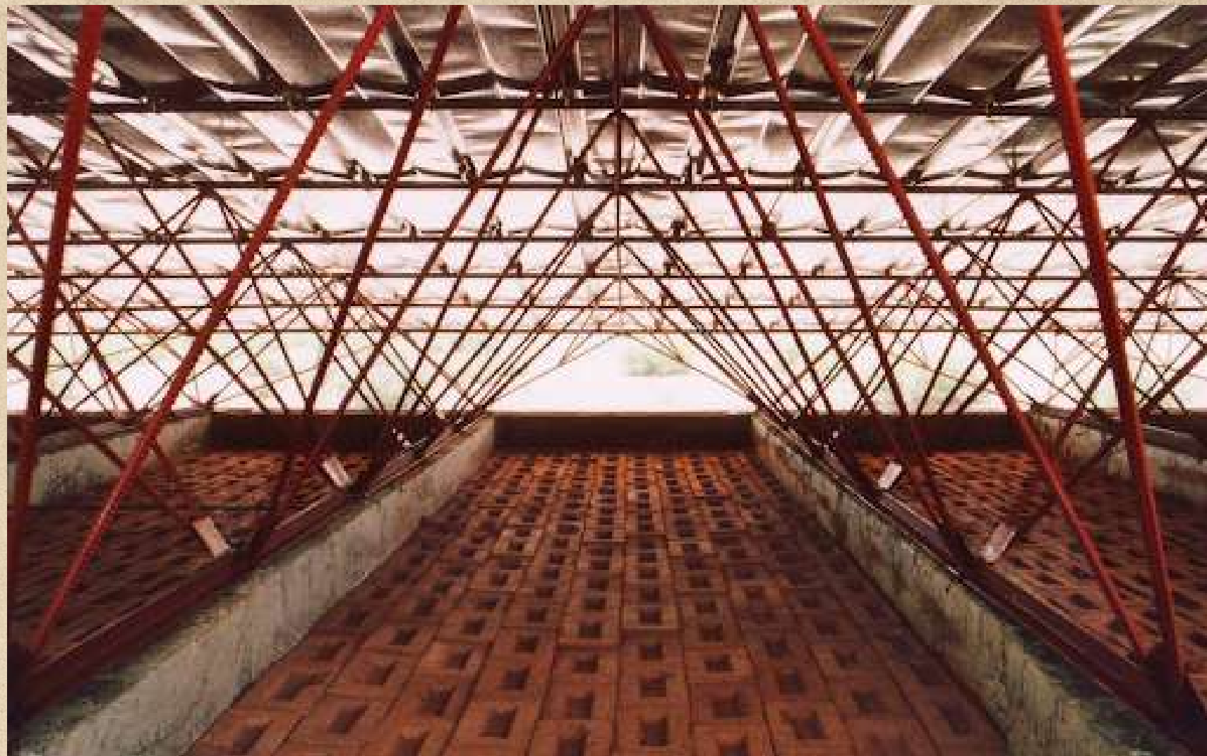
Detalhe do telhado da escola primária em Gando. Foto de Kéré Architecture
