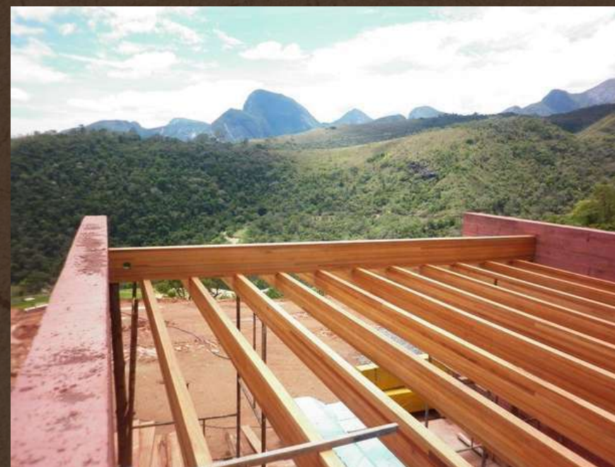
Residência ELC. Foto de ITA Construtora
