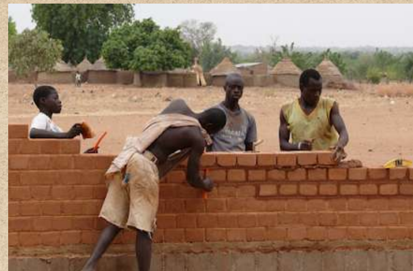
Amostras de blocos de argila e construção de uma parede de adobe. Fotos de Francis Kéré
