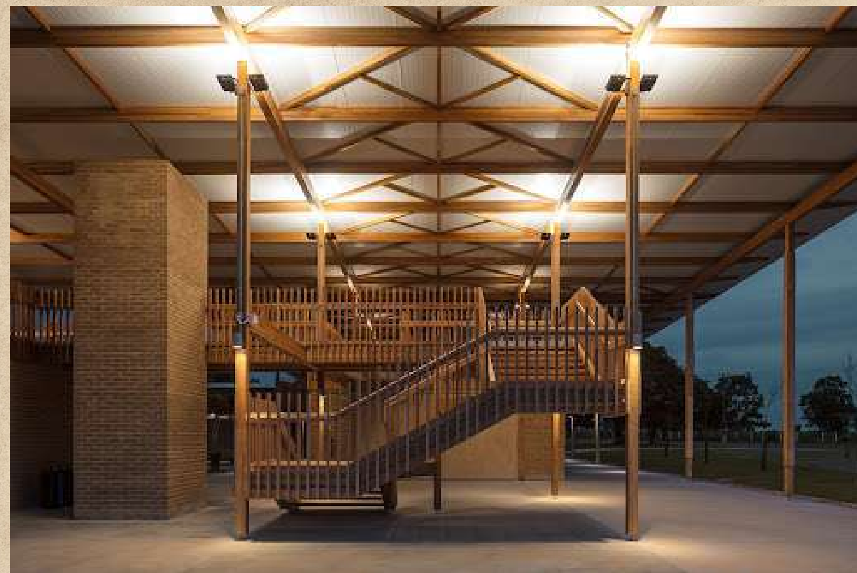
Edifício estrutural de MLC da morada infantil Canuanã. Foto de Leonardo Finotti
