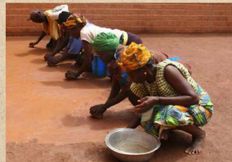
Polimento do piso de taipa e reboco de barro tradicional. Fotos de Francis Kéré
