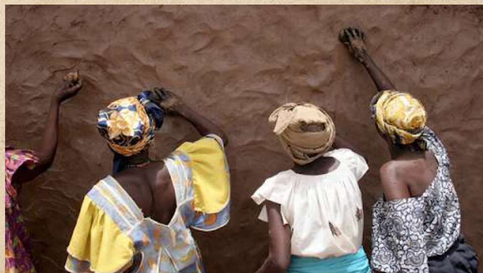
Polimento do piso de taipa e reboco de barro tradicional. Fotos de Francis Kéré
